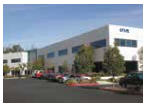
FLIR Santa Barbara
